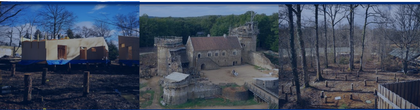
Les pieux bois de fondations devant les vestiaires du Château de Guédelon en construction. Photos 1 et 3 : Christian Nancey
